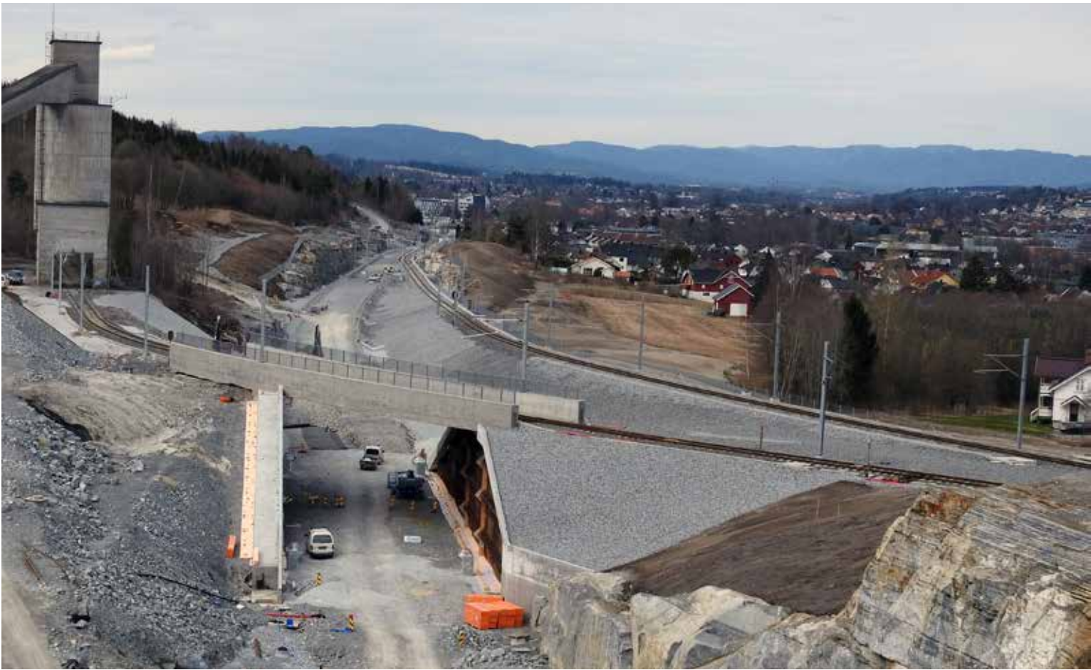
Byggingen av den dobbeltsporede Grenlandsbanen skrider sakte men sikkert frem, og vil i følge analyser både løfte togtrafikken og veksten i områdene rundt Grenlandsbanen betraktelig.
